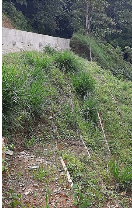
Figura 12. Zona de estudio y muro de contención
