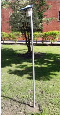
Figura 14. Instalación del prototipo
