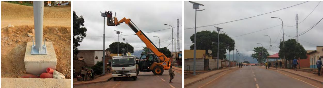
Figura 4: Cimentación, instalación y puesta en marcha de la instalación.
