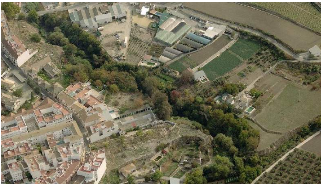
Figura 8. El tramo 5, a pesar de tener un estable bosque de ribera, sufre los impactos que le producen la urbanización (margen derecha) y la zona de naves comerciales (margen izquierda) a ambos lados del río. La imposibilidad de acceder al río por ambas márgenes, la acumulación de vegetación muerta en el cauce, de basuras y escombros, y el vertido desde los colectores son un problema añadido a la inestabilidad de la primera parte de la margen derecha del tramo. (Fuente: http://www.bing.com/maps/ )
