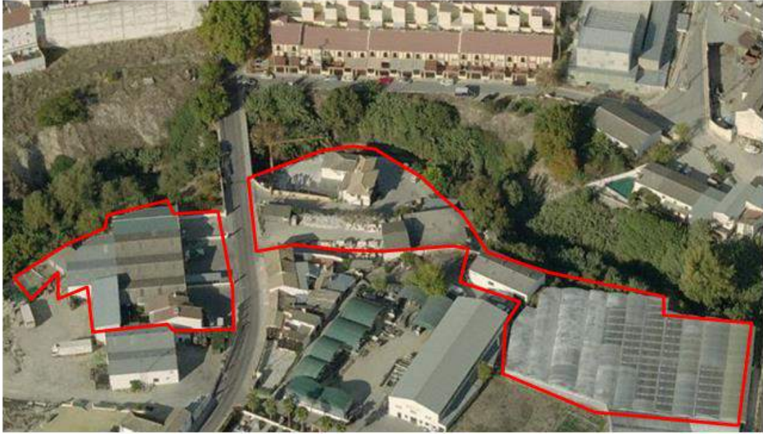
Figura 13. Localización de construcciones, naves industriales e invernaderos, que invaden la zona de servidumbre y la ribera del río en los tramos 4 y 5 objeto de proyecto.
