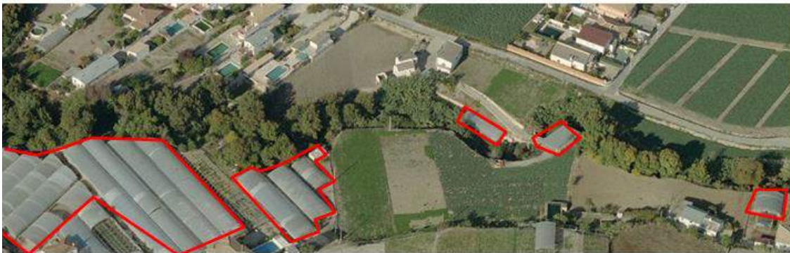
Figura 9. Localización de construcciones, naveas agrícolas e invernaderos, que invaden la zona de servidumbre y la ribera del río en los tramos 2 y 3 objeto de proyecto.
