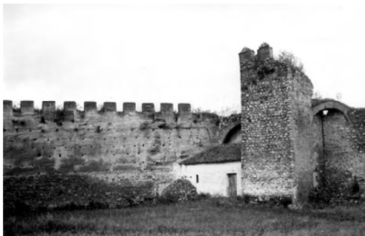
Fig. 3. Paño de muralla de hormigón árabe montado sobre mampostería de piedra. La torre albarrana que vemos se comunicaba por medio de un adarve con la torre del Ayrado, hoy desaparecida.
