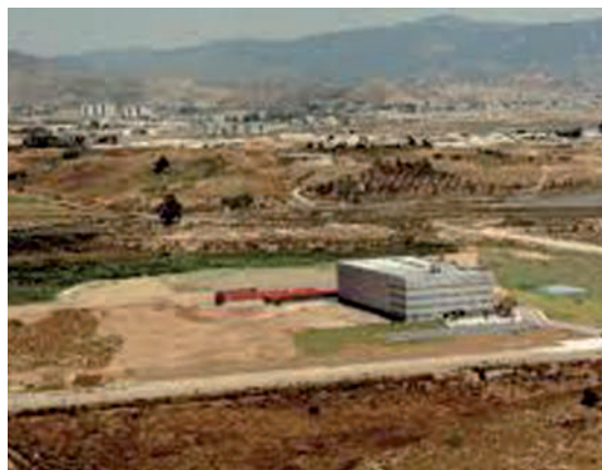
Figura 2. Fábrica de Fujitsu en el Polígono del Guadalhorce, Málaga.
