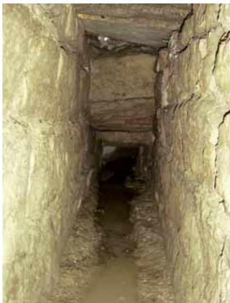
Fig. 16. Estrangulamiento del caño (2004).
