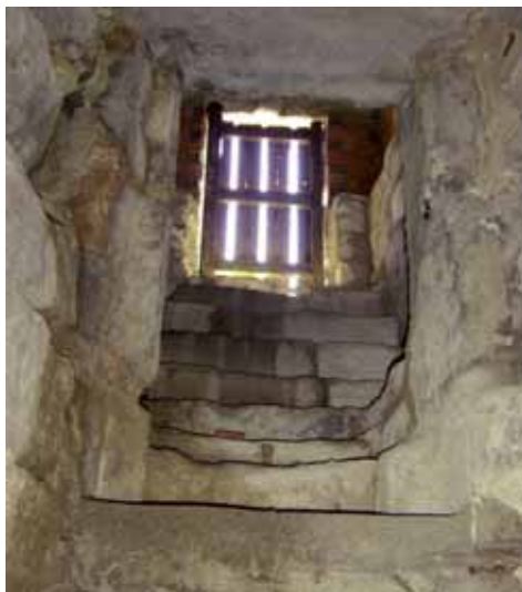
Fig. 7. Inicio de la escalera (2004).
