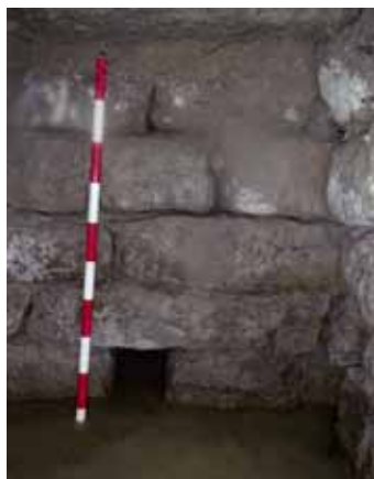
Fig. 13. Detalle constructivo del edificio (2017).
