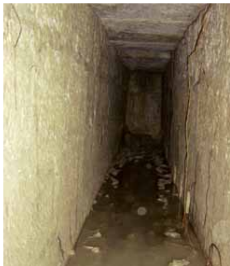
Fig. 10. Detalle del dren lateral (2004).
