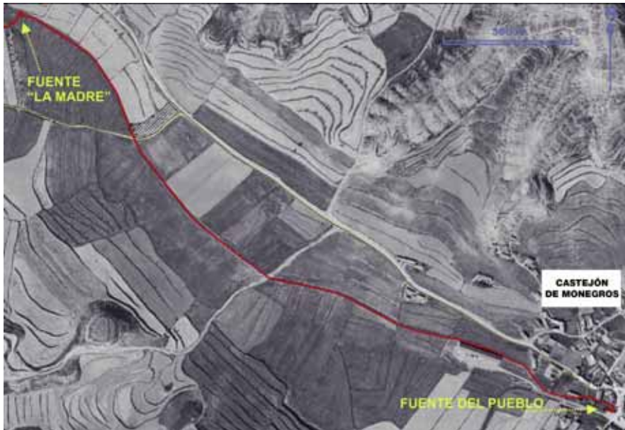
Fig. 2. Vista aérea de la captación y la galería de La Madre de Castejón de Monegros.
